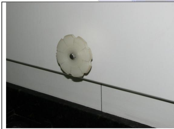
Manípulo: para ajuste das chicanas de ventilação.
