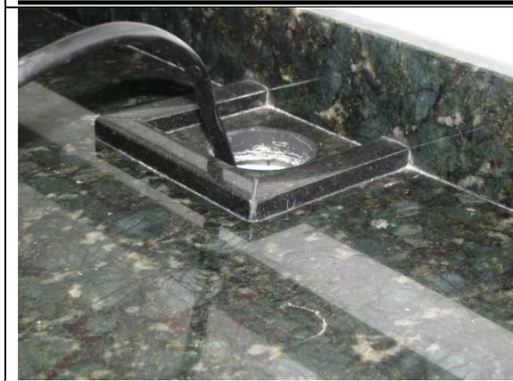
Passa-Fio: orifício de passagem dos fios dos equipamentos usados na capela, para até as tomadas, também serve para a ventilação do gabinete inferior(se houver)
